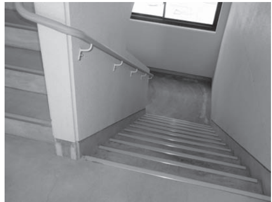
図7 階段すべり止めと手すりの設置 (物質工学科新棟)
