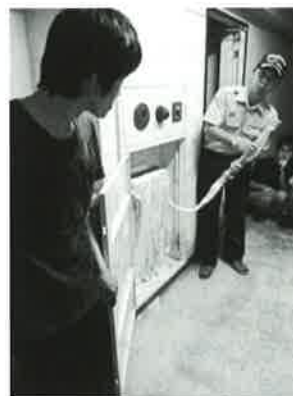
消防署員から屋内消火栓の操作方法を聴講する寮生
