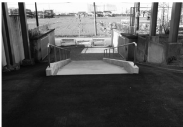
スロープ改修（手摺付階段設置）状況
