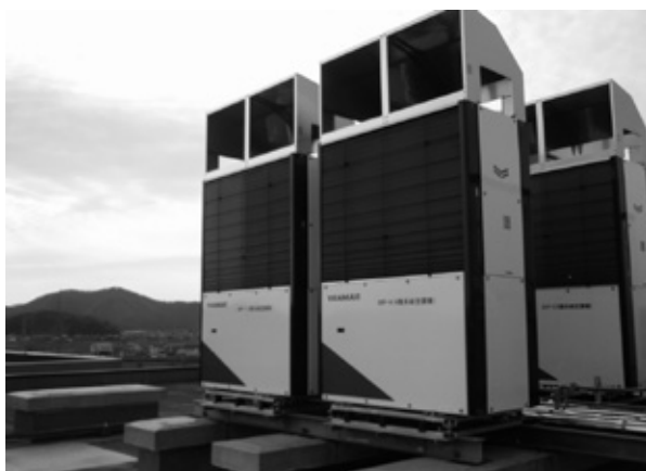
専攻科屋上空調室外機更新
