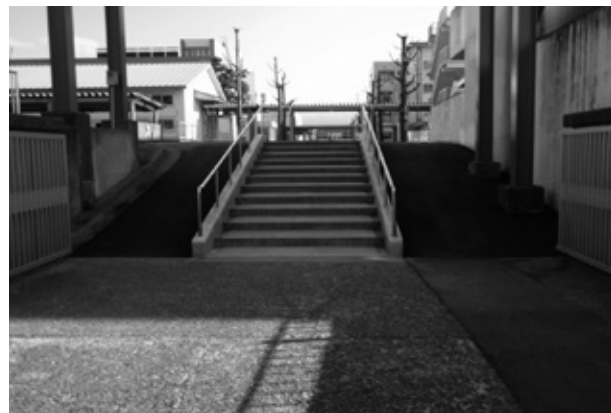
スロープ改修（手摺付階段設置）状況
