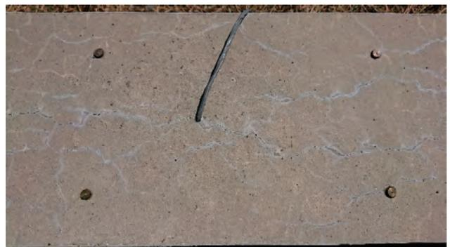
ASR による膨張ひび割れ
