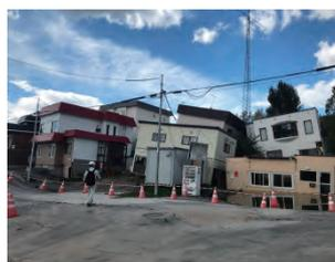
写真1 傾斜した家屋（液状化）
