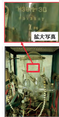
上図：鹿児島大学博物館所蔵に係る直流電源内蔵の水銀整流器に関する履歴調査から
