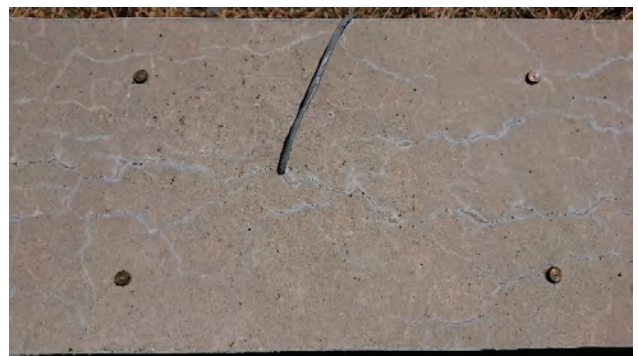
ASR による膨張ひび割れ
