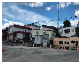
写真1 傾斜した家屋(液状化)
