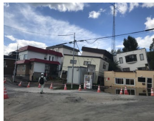
写真1 傾斜した家屋（液状化）
