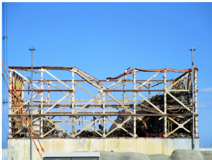
水素爆発した福島第一原発1号機建屋(左)と、放射線を除去した処理水(右) (2022. 9. 16 福島第一原発廃炉処理現場にて)
