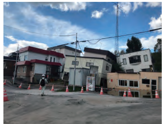
写真1 傾斜した家屋(液状化)
