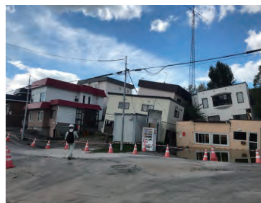
写真1 傾斜した家屋(液状化)
