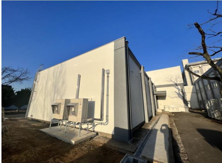
総合情報処理センター南側 外観
