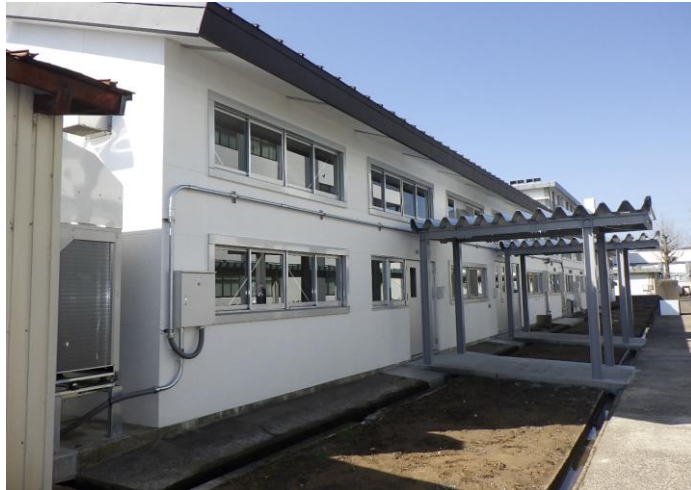
機械実習工場北側 外観
