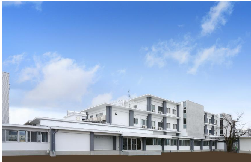
学寮中央棟北側 外観
