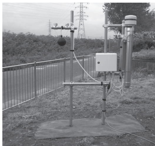
図1 WBGT自動測定システム(測定部)
