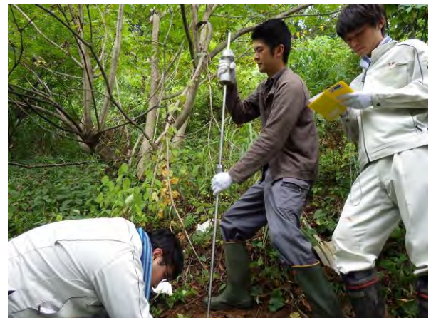
図1 簡易動的コーン貫入試験の様子
