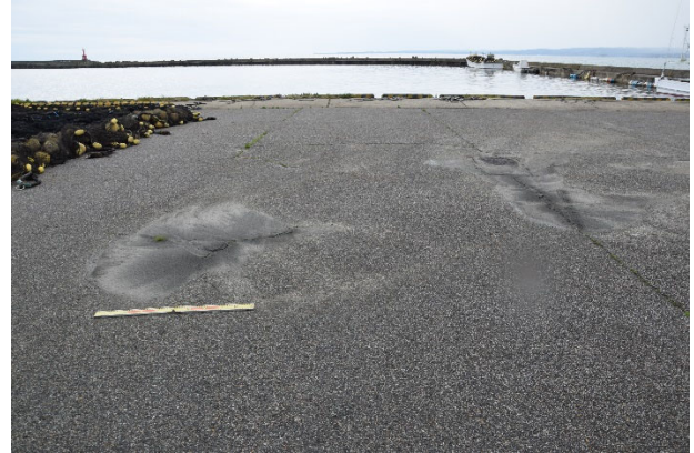
図 15 蛸島漁港の噴砂 (図 1⑦)
