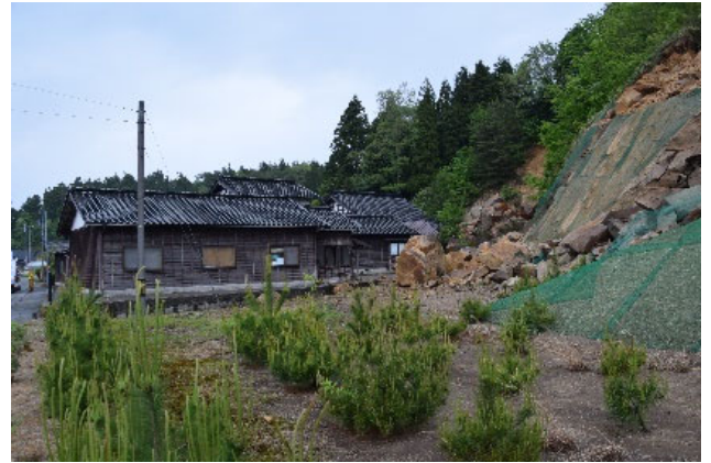
図 10 崖崩れによる家屋の半壊 (図 1④)
