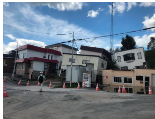
写真1 傾斜した家屋(液状化)
