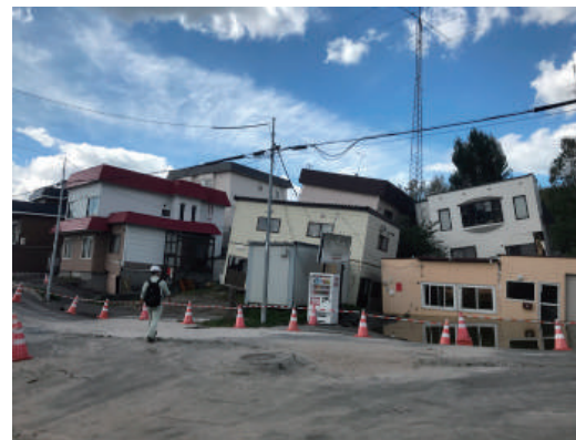
写真1 傾斜した家屋(液状化)
