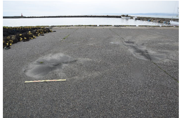
図 15 蛸島漁港の噴砂 (図 1⑦)
