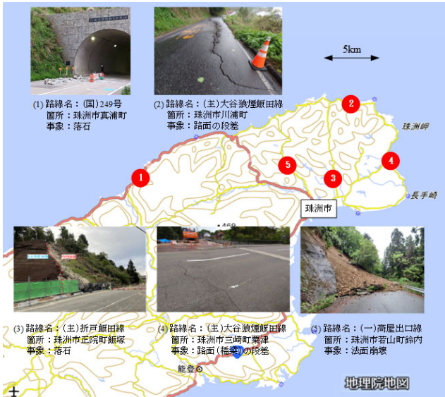
図8 県管理道路の通行止めの状況
