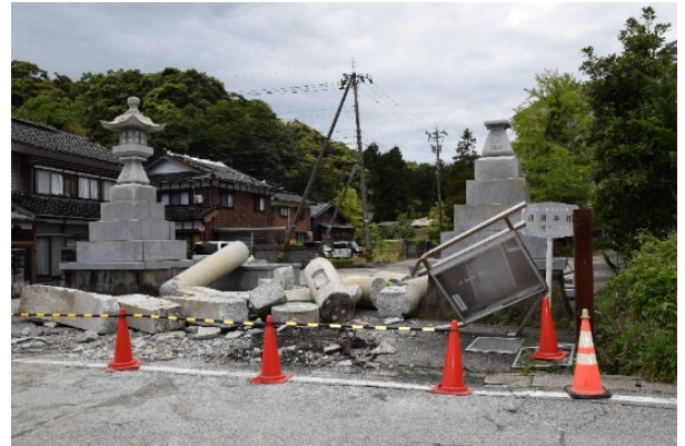
図 4 神社の鳥居の倒壊(図 1③)
