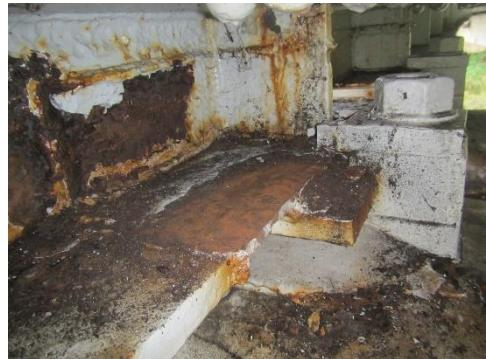
伸縮装置が損傷または劣化してくると、橋梁上面から雨水や土砂、ゴミなどの他、冬季は凍結防止剤を散布するためこれらが侵入してくることになります。その後、侵入してきたものが下部構造の上面や支承周辺に堆積し、主桁の端部が頻繁に湿潤したり、凍結防止剤の塩分が残留しやすくなり、結果として写真のように鋼材が腐食したり、コンクリートが損傷することにつながり、橋梁の安全性が低下します。
