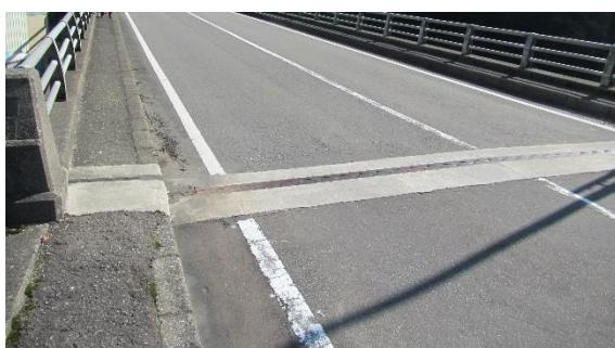
上図および写真のように、伸縮装置とは橋梁の路面端部に設置されるものであり、気温の変化による橋梁の伸縮、車両の通行時や地震等に伴う橋梁の変形を吸収し、自動車や人が支障なく通行できるようにするための装置です。
