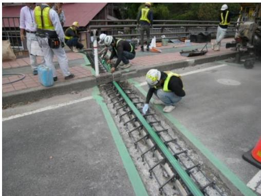
これまでの伸縮装置の補修は、伸縮装置周辺のコンクリートを取り壊し、左写真のように新しい伸縮装置に全交換するのが一般的でした。この方法の場合、通行規制が長くなり、比較的損傷が少ない部分も含めて交換する他、場合によっては橋梁下面に足場を組む等、大掛かりな補修工事が必要とされていました。
