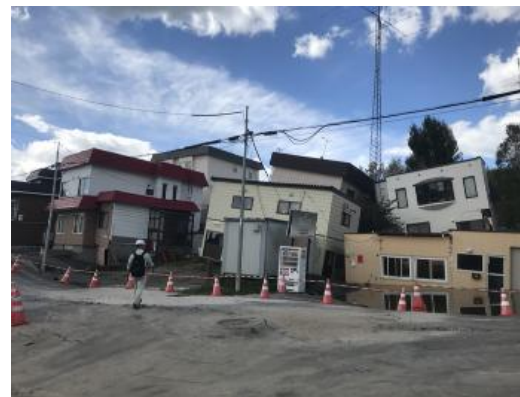
写真1 傾斜した家屋(液状化)
