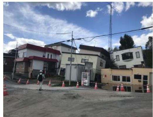
写真1 傾斜した家屋(液状化)
